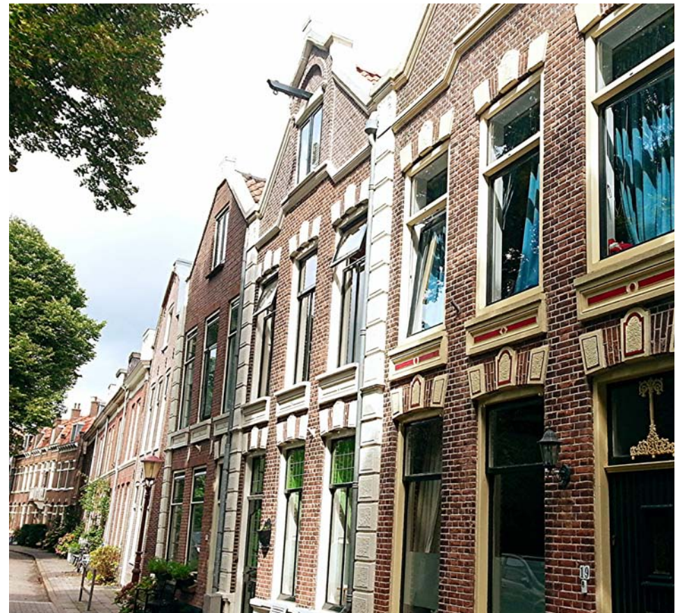
De Nieuwegracht Purmerend
